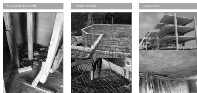
Figura 9. Sistema de losa sólida de concreto.
