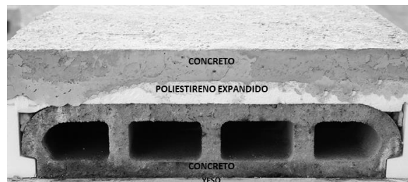
Figura 35. Capas del sistema de losa térmica.
