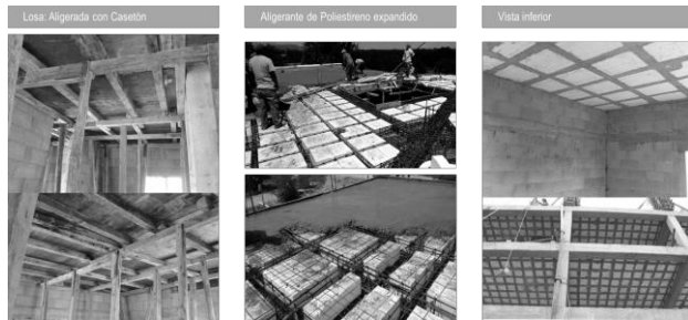
Figura 10. Sistema de losa aligerada con Poliestireno expandido.
