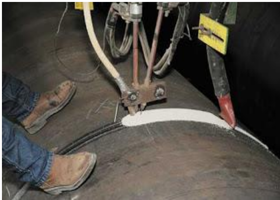
Figura 3. Soldadura por arco sumergido.
