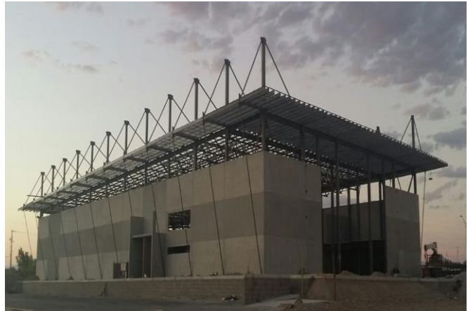
Figura 9. Edificio construido con paneles prefabricados de concreto.
