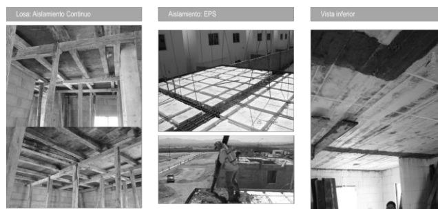
Figura 8. Sistema de losa aislada de manera continua.
